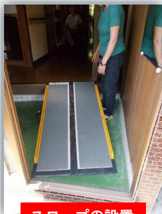
スロープの設置
